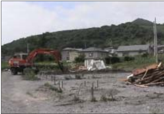
写真1 虻田町栄町地区の応急仮設住宅撤去現場
